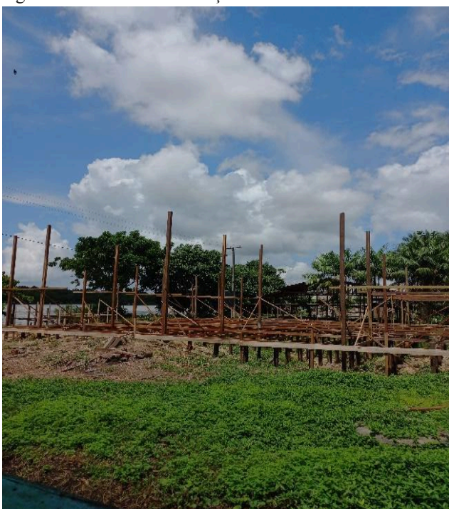
Figura 3- Escola em construção.
