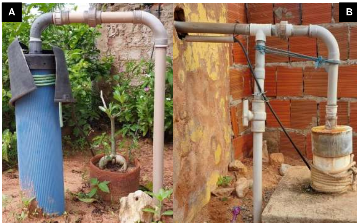
Figura 4 - Poços tubulares: (A) PVC geomecânico e (B) PVC convencional
