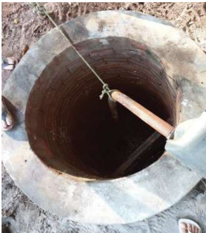
Figura 5 - Poço do tipo cacimbão com revestimento em alvenaria
