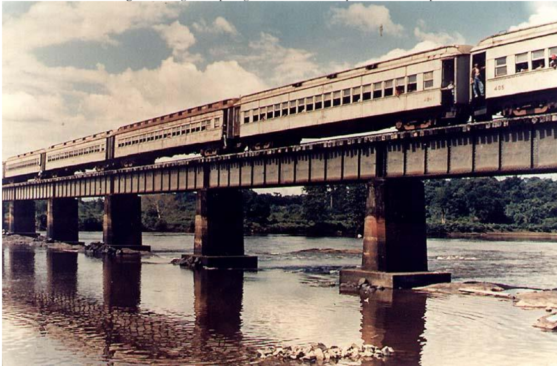
Figura 4 - Vagões de passageiros atravessando a ponte do rio Amapari
