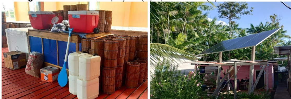
Figura 2 - Subsídios do projeto: (A) Apetrechos e (B) Placas solares
