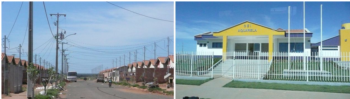
Figura 7. Conjunto Habitacional no município e Escola em área de habitação popular no município de Lucas do Rio Verde.
